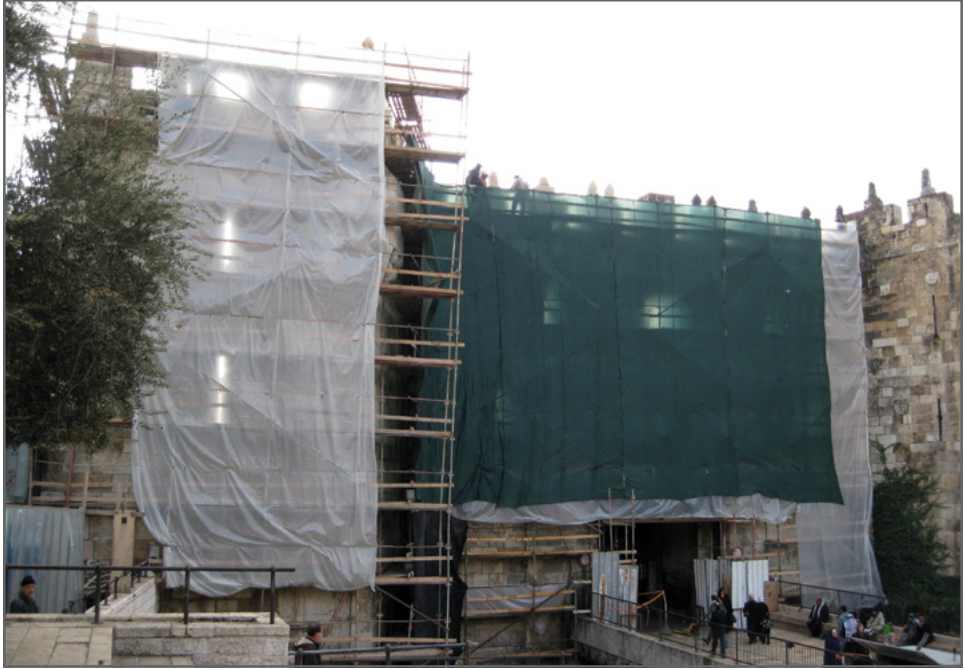
الصورة رقم 3: أعمال ترميم وحماية في باب العامود
