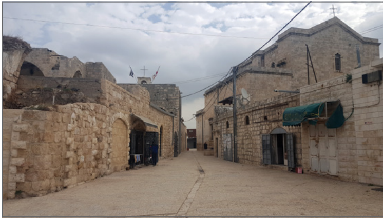
الصورة رقم 5: أعمال ترميم في واجهة شارع الكنائس في اللد
